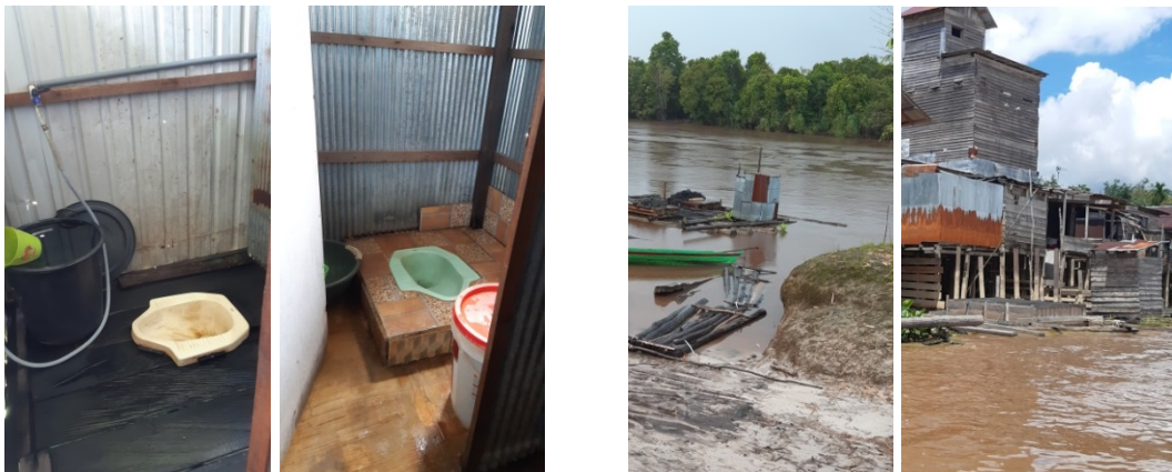
Gambar 2. Sarana MCK dengan Septic Tank (kiri) dan tanpa penampungan (kanan)
